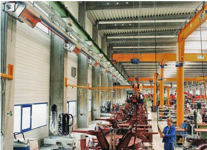
Рисунок 6.2 - Інфрачервоне опалення промислового приміщення
