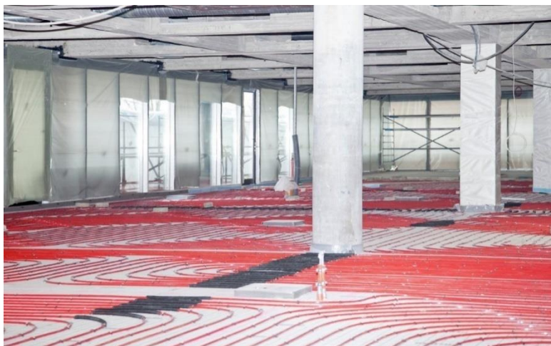
Рисунок 6.4 - Опалювальна система «тепла підлога» в промисловому приміщенні
